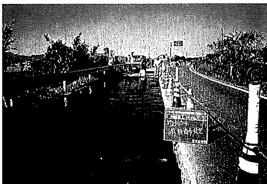
写真—6 養生（瀝青材散布）状況
