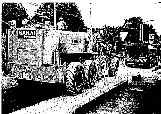
写真—4 不陸整正・敷均し状況
