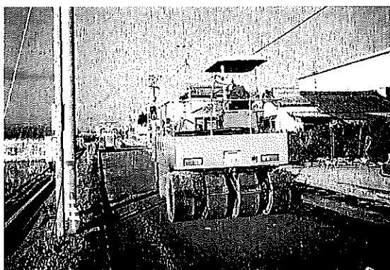
写真—6 養生（瀝青材散布）状況
